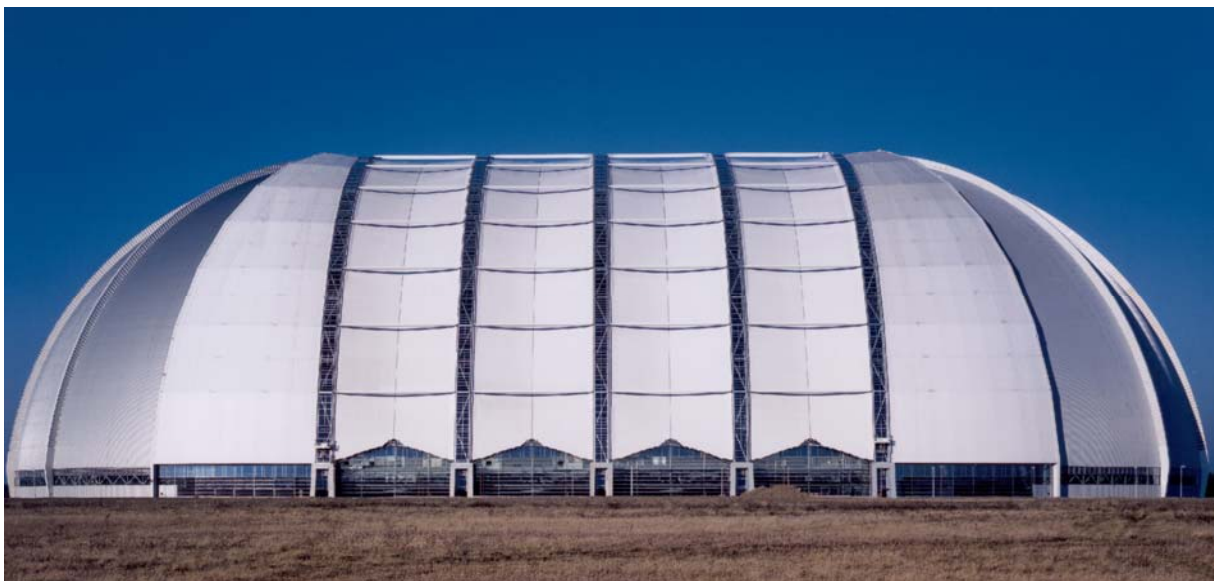
Bild 7.8 Cargolifter-Halle in Brand (Brandenburg) nach Fertigstellung
