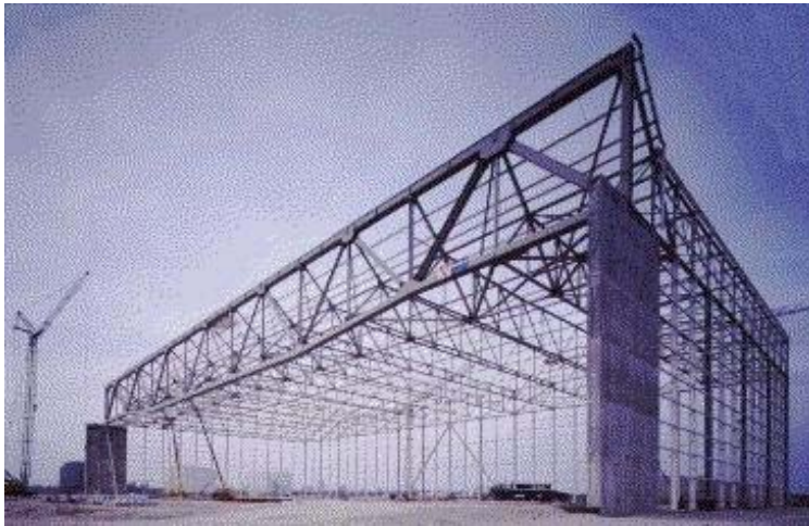
Bild 7.6 Stählerne Tragkonstruktion der Flugzeugwartungshalle am Flughafen Franz-Josef-Strauss in München
