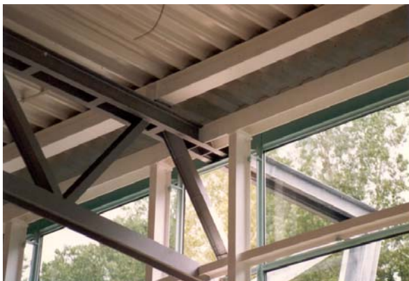
Bild 7.11 Durchdringung Riegel/Fassade
