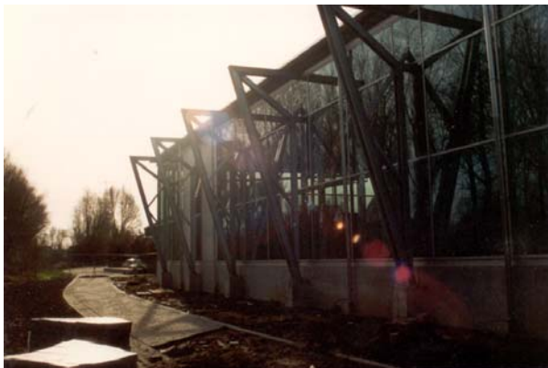
Bild 7.9 Fassade der Turnhalle in Würth am Rhein
