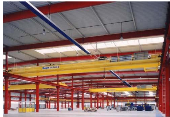
Bild 7.2 Mehrschiffige Industriehalle mit Krananlage
