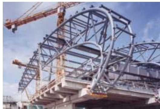
Bild 7.17 Montage des Tragsystems
