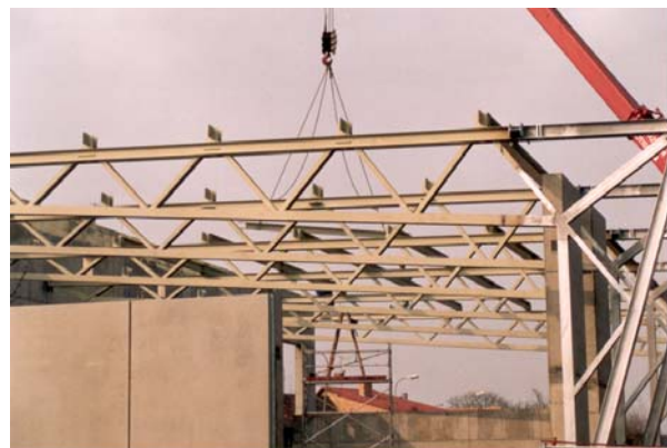
Bild 7.12 Montage der Hallenrahmen
